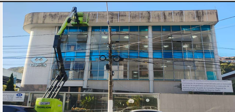
Foto 2: TÉRREO FACHADA: Instalação de ACM em andamento
