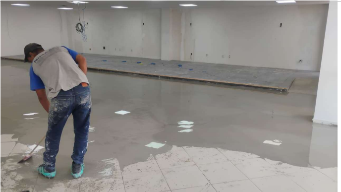
Foto 19: 3º Pavimento: instalação autonivelante para aplicação do carpete;
