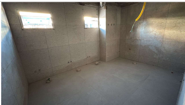
Foto 18: 2º PAV. : Instalação de revestimentos concluída
