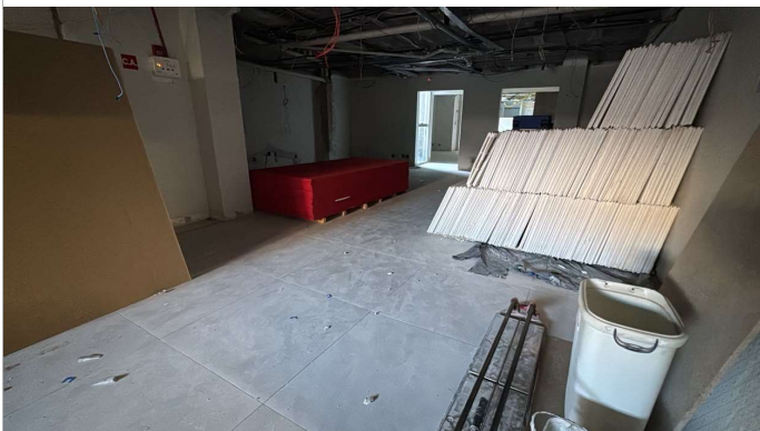
Foto 4: TÉRREO FACHADA: Instalação de revestimento concluída
