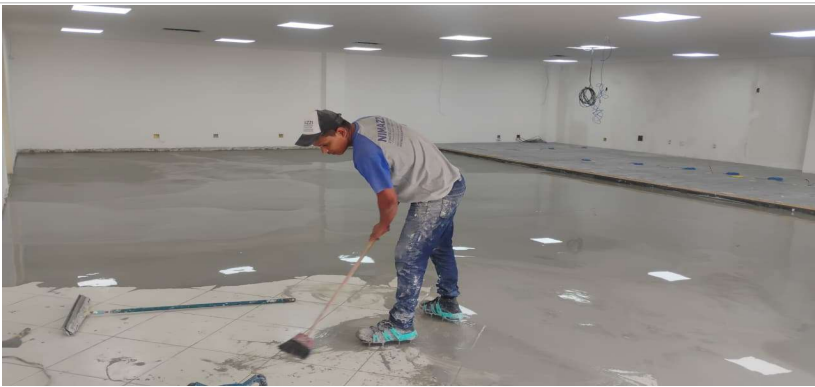
Foto 20: 3º Pavimento: instalação autonivelante para aplicação do carpete;
