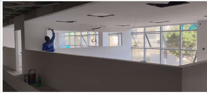
Foto 11: 3º pav. Instalação de forro no hall do café
