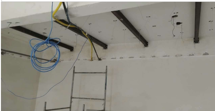
Foto 25: Prédio 03: Reforço estrutural em andamento
