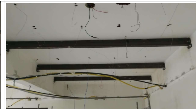
Foto 27: Prédio 03: Reforço estrutural em andamento
