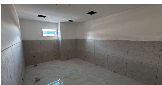
Foto 19: 3º Pavimento: instalação autonivelante para aplicação do carpete;
