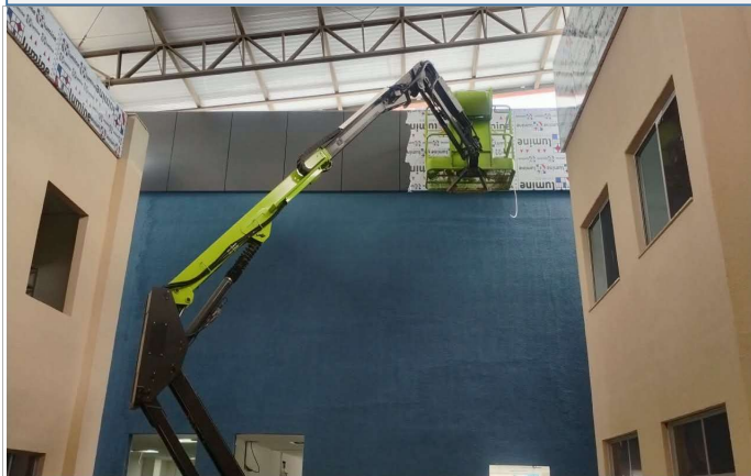
Foto 7: TÉRREO FACHADA: Instalação de acm e regularização fachada
