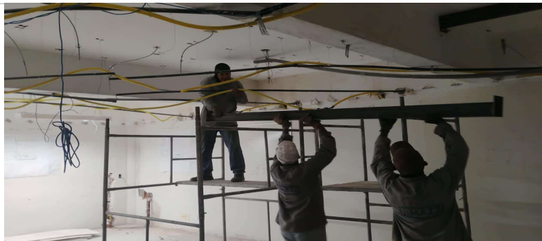
Foto 26: Prédio 03: Reforço estrutural em andamento
