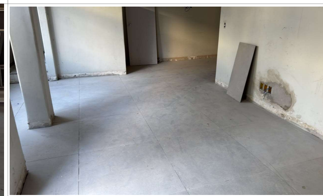
Foto 6: TÉRREO FACHADA: Instalação de revestimento concluída
