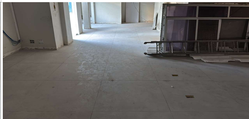
Foto 5: TÉRREO FACHADA: Instalação de revestimento concluída
