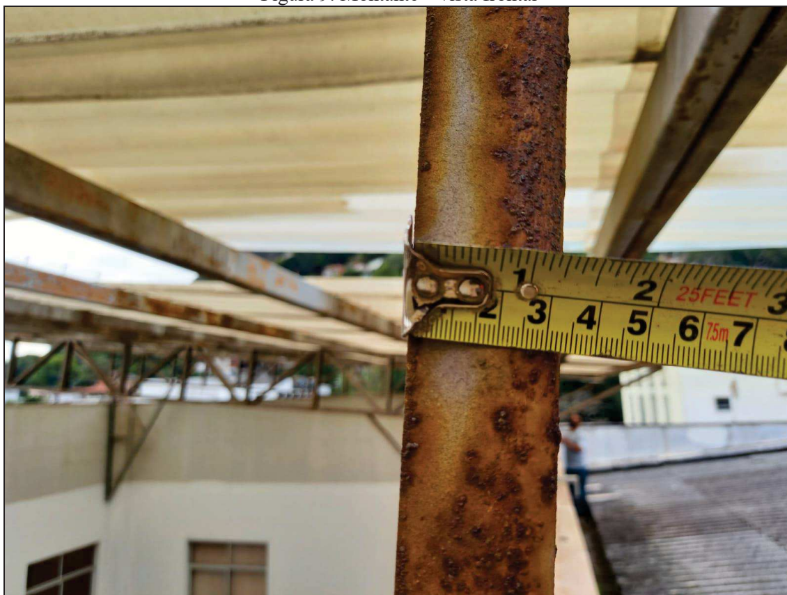
Figura 9: Montante – vista frontal
