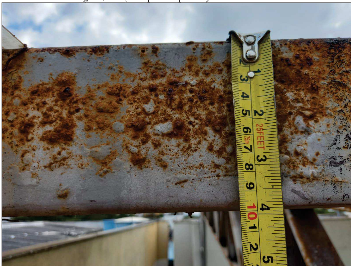
Figura 7: Terça em perfil duplo enrijecido – vista lateral
